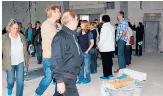
Architekt Volker Helbig (vorne in schwarz) führte interessierte Gäste durch das neue Gebäude, das noch eine komplette Baustelle ist.
