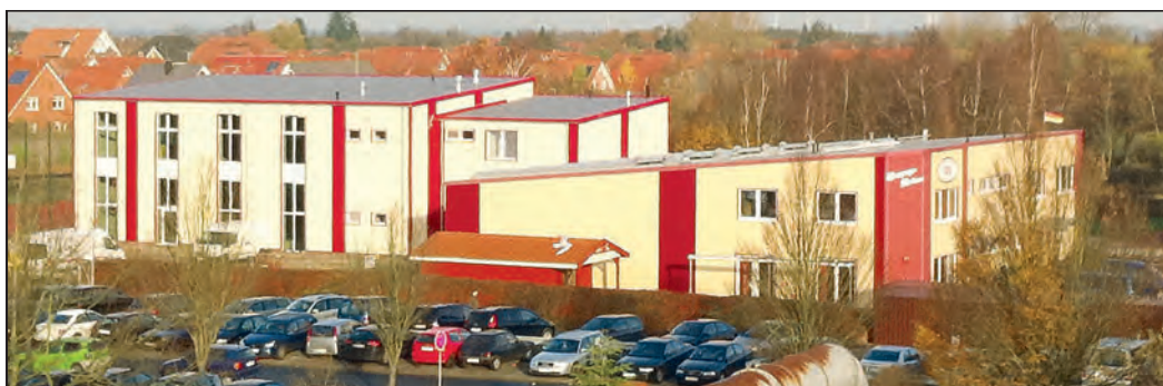
Der Neubau (links) wurde direkt hinter den bestehenden Bau gesetzt.
