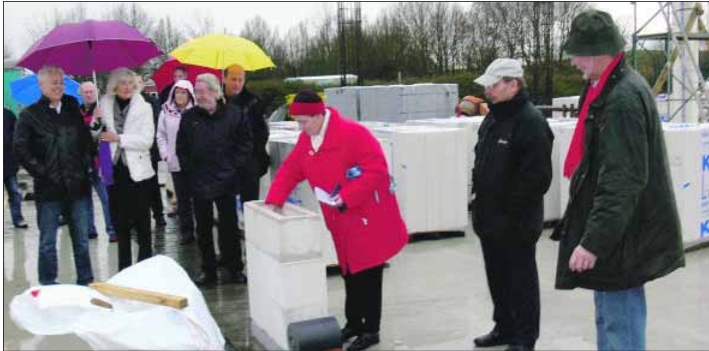
Der Grundstein mitten in der Legung: Bürgermeisterin Lina Meyer platziert gerade die Dokumentenrolle im Grundstein. Im Hintergrund unter dem violetten Schirm ISV-Vorsitzende Ilse Meier neben SPD-Ratsfraktionschef Hans-Dieter Haase. Rechts Architekt Volker Helbig und Bauunternehmer Tamme Heuermann. EZ-Bild: Kahle
